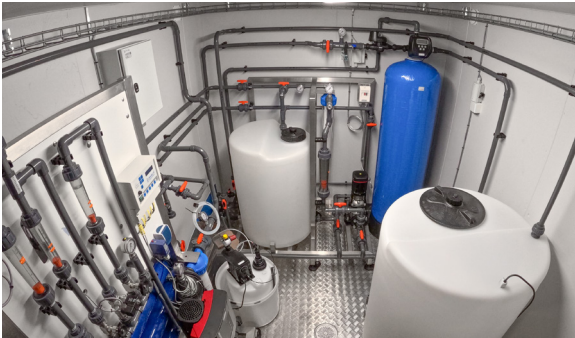
Helintegrerad processutrustning för effektiv, automatiserad och tillförlitlig PFAS-rening.
